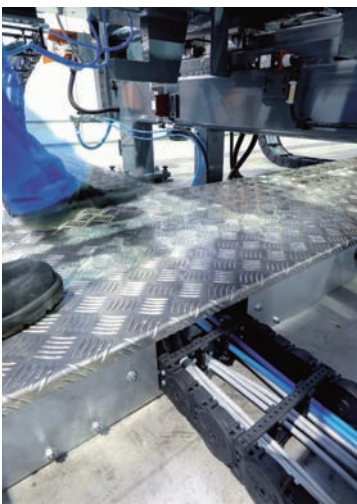
Obr. 2 Realizácia technologického výstupu zo žľabu BKRS
